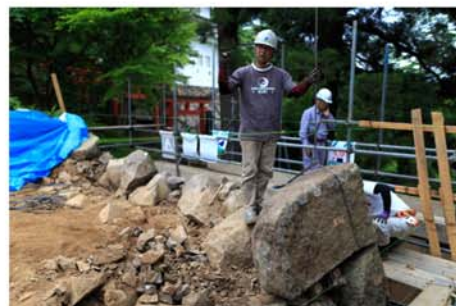
出石城山里曲輪石垣修復工事
