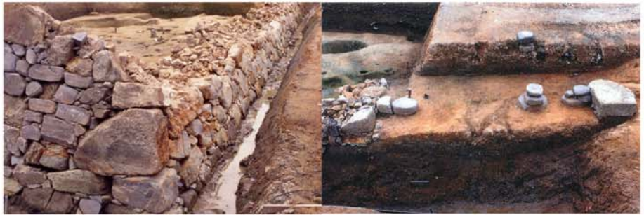
石垣北東隅角
