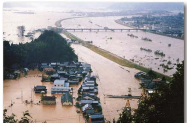
台風23号の被害(豊岡市山本から南を望む)
