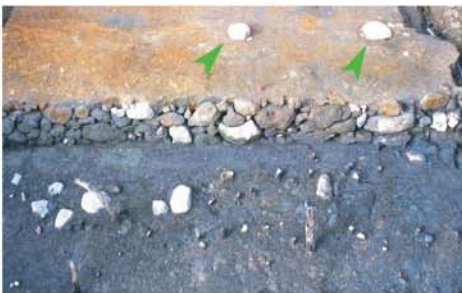
玄武洞の玄武岩を使った礎石 豊岡市京町・豊岡城跡出土 (江戸時代)
