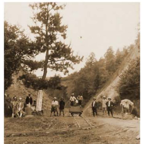
建設工事の様子(中筋～大谷間) [撮影年不明/提供:松本源明]
