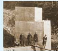
鶴岡橋梁の建設工事 〔昭和 3 年 (1928) / 提供: 松本源明〕
