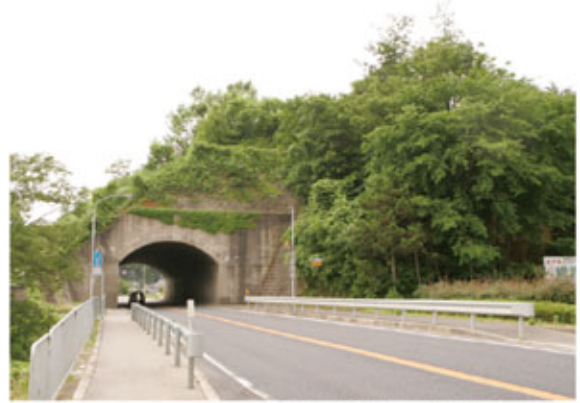
城ノ山古墳の現況（北から）
