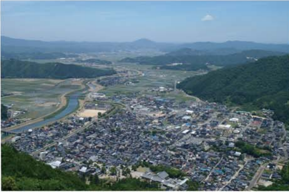
有子山城跡から見た出石の町並み
